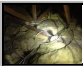
loose wiring
